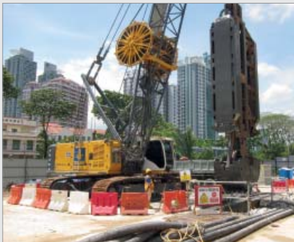
Herstellung mit Greifer oder Fräse
