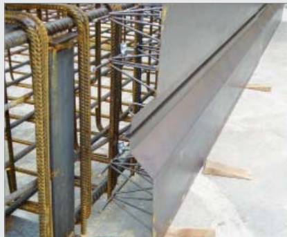
Fugenblech mit Fugenband
