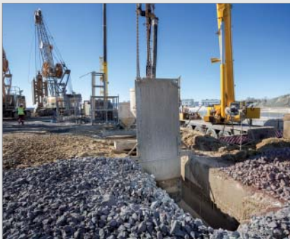
Temporäres Abschaltbohlen-System – Bauer
