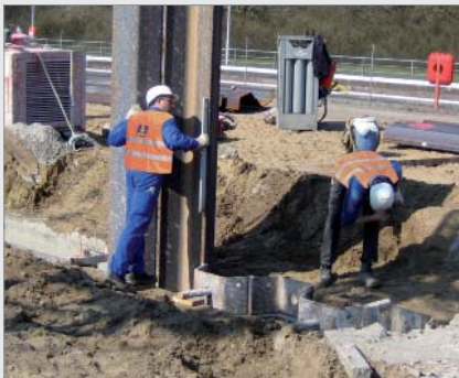
Einstellen der Spundwandelemente
