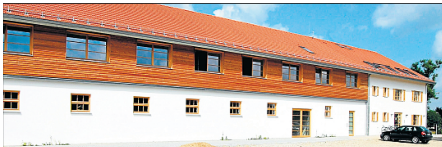
Dass das Kreisgut einst ein Bauernhof war, ist auch nach der Sanierung deutlich erkennbar. Das obere Stockwerk (mit Holzfassade) wurde neu errichtet, darunter befindet sich der historische Baubestand, in dem einst Ställe und Remisen untergebracht waren.
