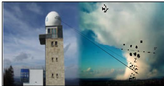
Ein Dopplerfilterverfahren entfernt die sogenannten Clutter. Clutter sind Festechos, die durch hohe Gebäude oder Hügel verursacht werden.
