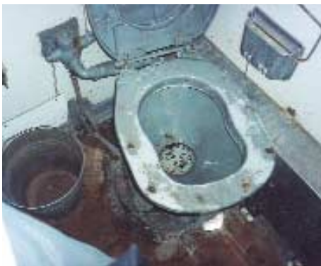
Klappenklosett mit Hebelmechanismus in einem ukrainischen Zug im Sommer 2002.
