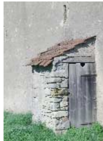
Drei Plumpsklos und drei regionale Bauweisen: Fachwerk, Naturstein und Massivbau aus Backsteinen. Oben in Thüringen, links unten Wincheringen-Söst, Rheinland-Pfalz, rechts Verden an der Eitze.
