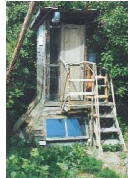
Großes Kompostklo mit Luxus im Eigenbau gefertigt: Luftvorwärmung neben der Treppe, Durchlüftungsröhr mit Zugverstärkung durch Sonnenwärme.
