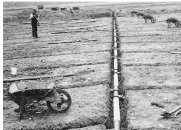
Feldberieselung mit unterirdischer Drainage zur Düngernutzung von Fäkalien.
