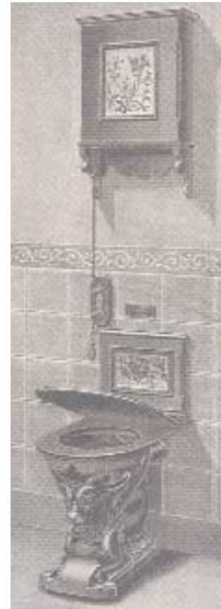
Um 1897 wurde dieses Hochreservoir-Closet Type Nautilus in einem Verkaufsprospekt der Wiener Firma Heinrich Enders angeboten. Über die damalige Verbreitung von Wasserklosetts spricht der Werbezusatz Bände: » Nur dort zu installieren, wo Wasserleitung vorhanden «.
