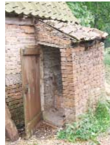
Drei Plumpsklos und drei regionale Bauweisen: Fachwerk, Naturstein und Massivbau aus Backsteinen. Oben in Thüringen, links unten Wincheringen-Söst, Rheinland-Pfalz, rechts Verden an der Eitze.
