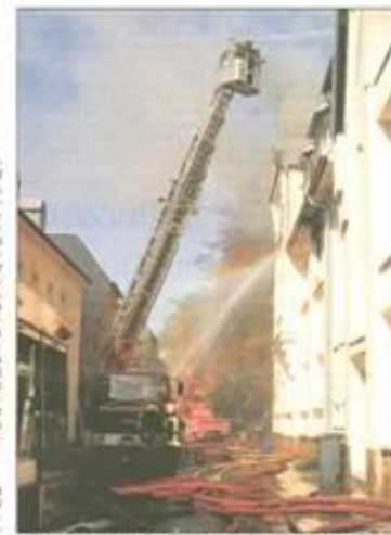
Gegen 5.42 Uhr waren die Einsatzkräfte von Feuerwehr, DRK und Katastrophenschutz zu dem Wohnhausbrand gerufen worden. Gegen 10.45 Uhr hatten sie nach langer mit Flammenrennen im Schichtdienst zu kämpfen.
